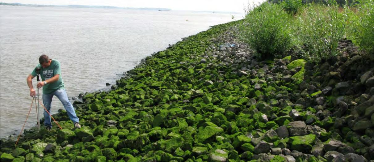
Abbildung 23: Deckwerk auf der Elbinsel „Lühesand“
